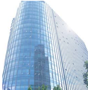
Platinum 新茂大厦 Investment Services, Sole Office Leasing Agency & Asset Management 投资服务、独家办公楼 租赁代理及资产管理 (34,000 sq m / 平方米)
